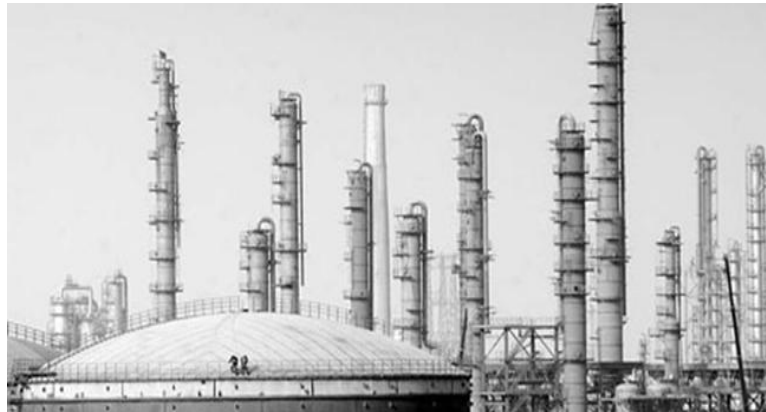
SINOPEC TIANJIN エチレンプロジェクト /攪拌機・コンベア用減 速機(写真右)
