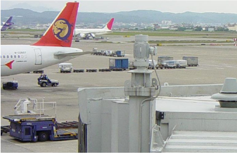
インドネシア/スラバヤ空港 コンベア用減速機(写真左)
